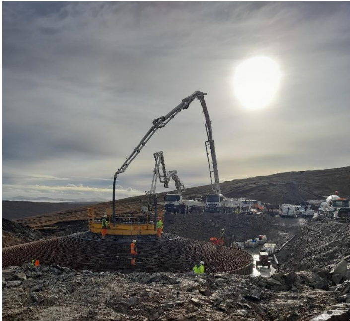
Photo 1. K43 turbine foundation concrete pour in progress
